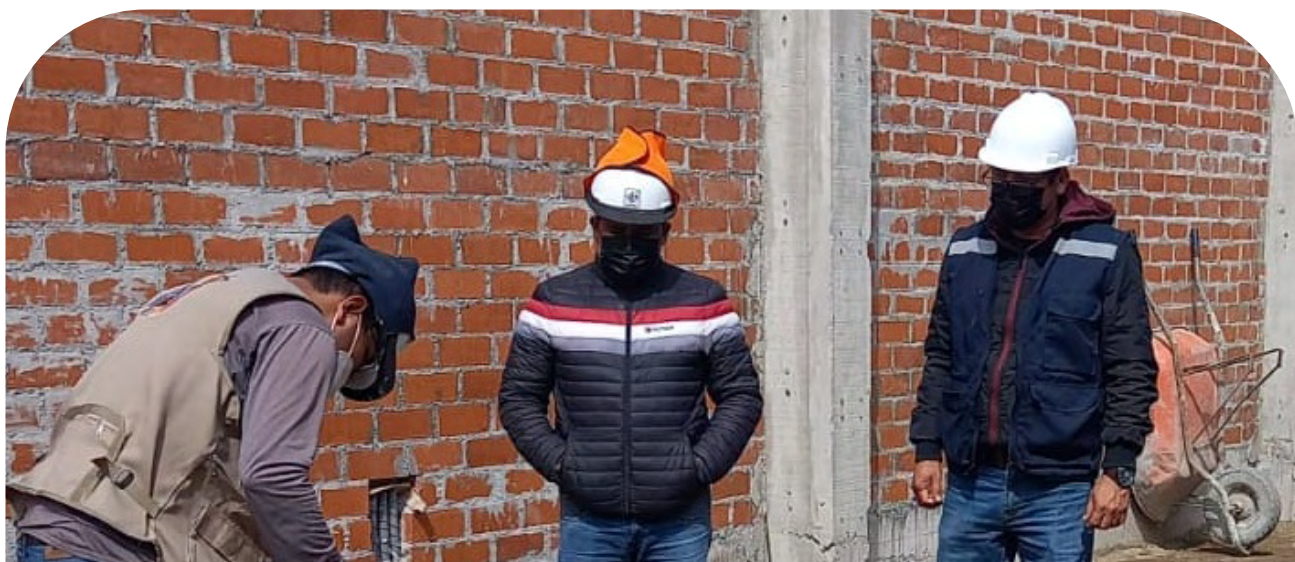
Control de calidad en obra
