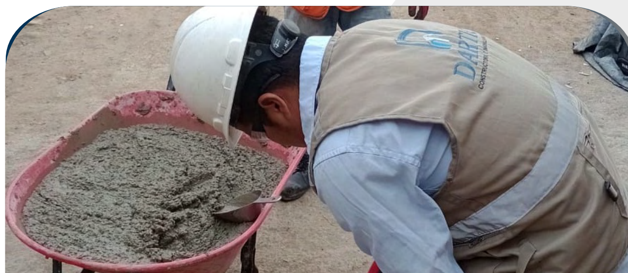
Prueba del Slump
